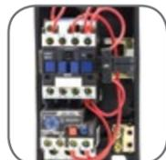
Пускатель состоит из корпуса, в котором закреплены контактор КМЭ и тепловое реле РТЭ в сборе
